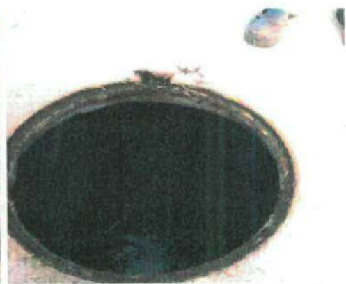
Cămin dren nou pentru by-pass în canalizare Cămin dren nou pentru by-pass în canalizare
