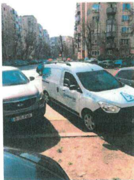
Asfalt neadus la cotă
