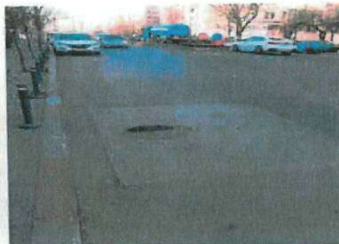
CCA2 placa la nivel asfalt
