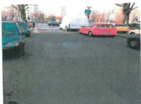
CCG1 placa la nivel asfalt
